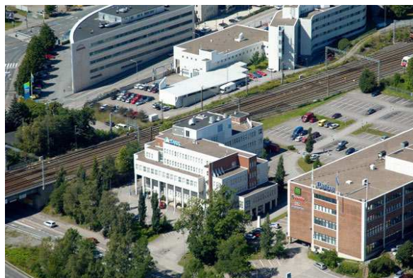
TAKK:n toimitalo on sujuvalla paikalla keskellä kaupunkia. Se oli pitkään lähes Pitkyn pääkonttori
